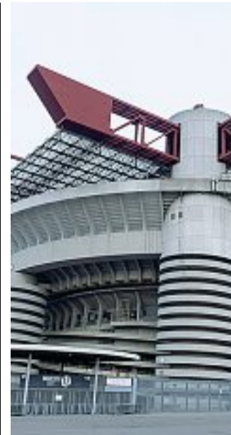
Vincolo light Il progetto prevede di demolire San Siro: resterà il secondo anello vincolato (LaPresse)
